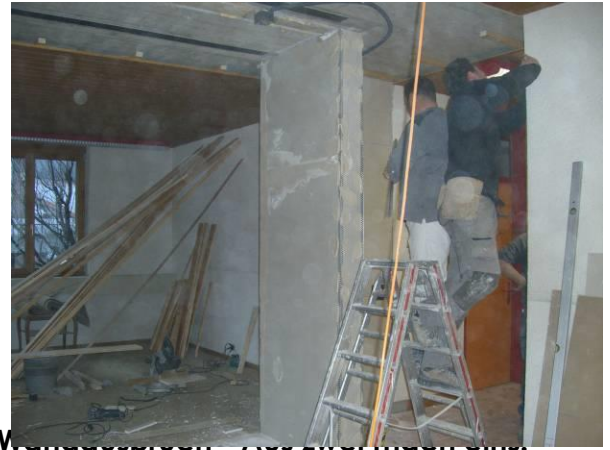
Wandarbeiten des Erdgeschosses
